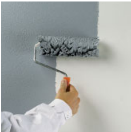
Einmalige Zwischenbeschichtung mit Spezial-Dispersionsfarbe Capadecor Alucryl mit kurzfloriger Rolle
