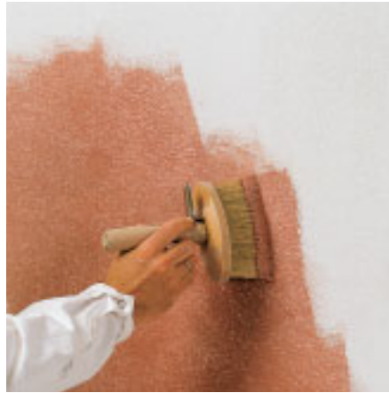
Nach Trocknung Schlußauftrag mit Arte-Lasur im kurzen Kreuzgang mit einer Bürste.
