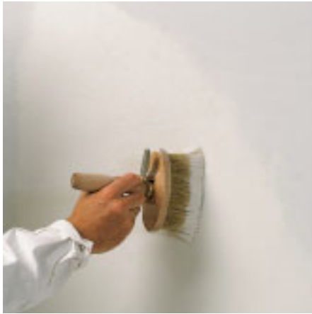
Weißer Grundbeschichtung mit dispersionsgebundenem Material
