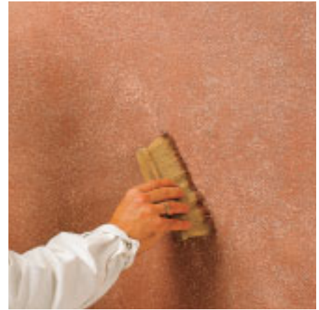
Nach wenigen Minuten verschliffen, z.B. mit einer Entstauber-Bürste, je nach gewünschter Optik.
